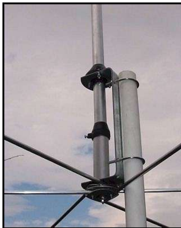
(detail uchycení spodního konce antény)
